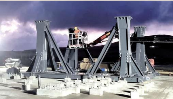
Made by Ostseestaal: Raketenstartrampe auf den Shetland Islands - die erste für vertikale orbitale Raketenstarts in Europa. Fotos: RFA - Rocket Factory Augsburg / Ostseestaal GmbH & Co. KG
